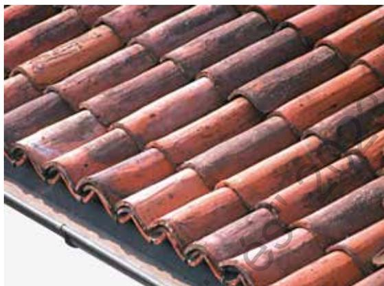
Fig. 3/402: Toit en tuiles Coppi formées à la main
