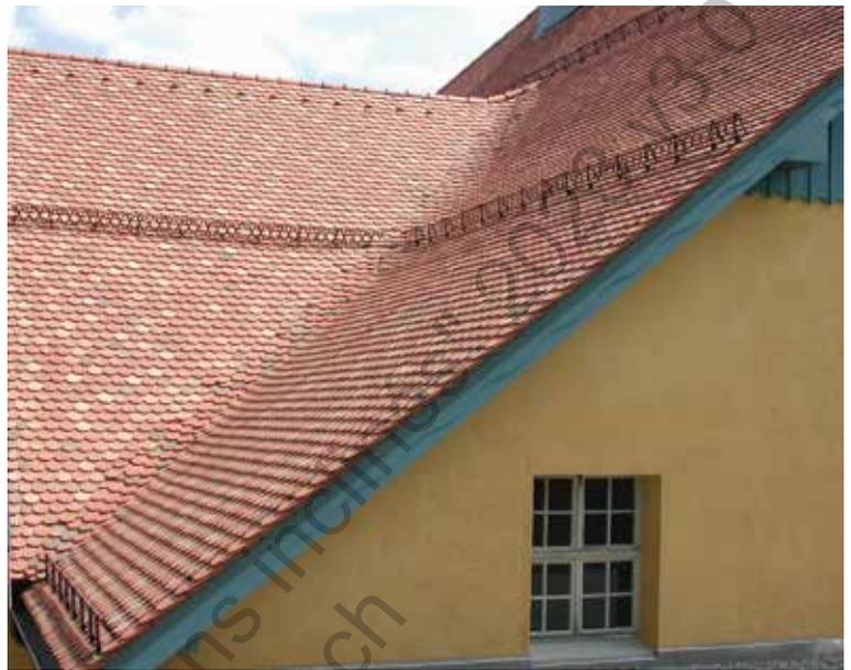
Fig. 1/258: Plusieurs pare-neige à grille répartis de façon efficace sur le toit
