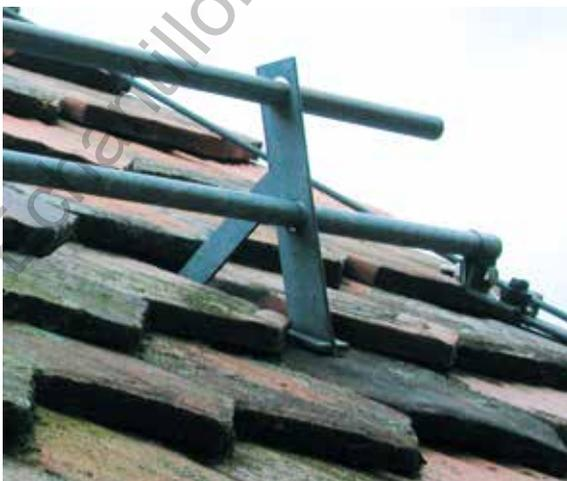
Une latte d'appuis ou une cale placée au pied du crochet permettent de transmettre les forces de pression à la charpente.
