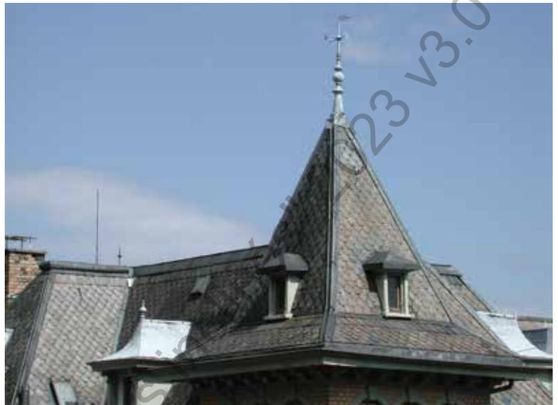
Fig. 1/102: Toit en ardoises
