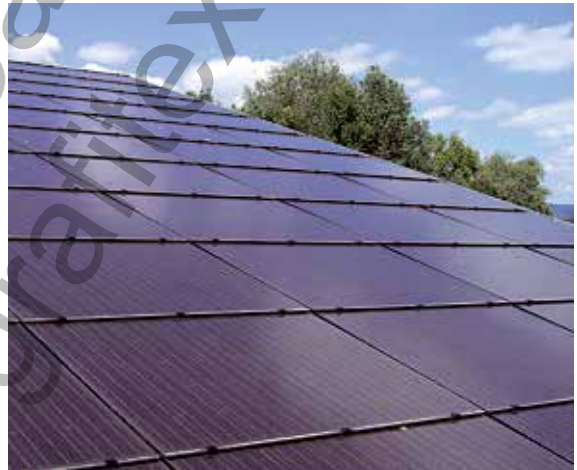
Abb. 1/105: Dach als Energiespender; Photovoltaik: Deckung mit Solarmodulen zur Stromgewinnung
