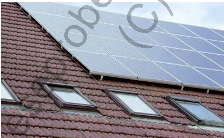
Abb. 1/264: Solarmodule; Montage über der Deckung
