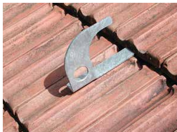
Abb. 6/201: Optimale Einbaustelle des Sicherheitshakens im Muldenziegeldach. Die Befestigung mittig in Konterlatte und Sparren hat jedoch erste Priorität!
