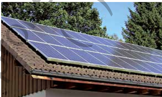
Abb. 1/104: Dach als Energiespender; Photovoltaik: Auf Dach montierte Solarmodule zur Stromgewinnung, Nutzen vor Ästhetik
